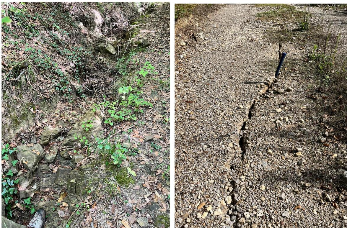
Figura 24: Solco di ruscellamento lungo il versante destro del t. Porcile (foto a sx). Frattura del sentiero che passa sul versante sinistro del t. Porcile (foto a dx).
