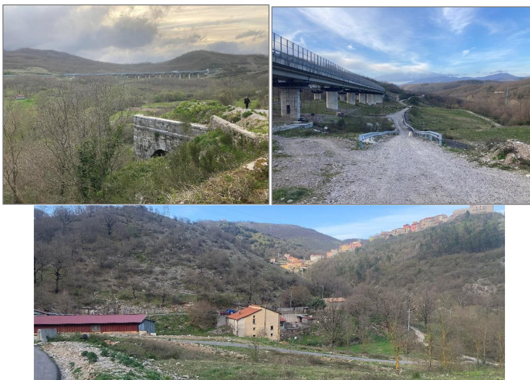
Figura 29: Sito C, interferenze. Sinistra-alto: galleria linea ferroviaria storica; destra-alto: viadotto autostrada E45; basso: vista degli edificati in fondo valle.
