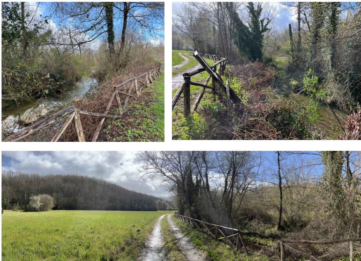
Figura 24: Immagini fotografiche del sito D. Alto: torrente Porcile; basso: zona d'imposta della diga.
