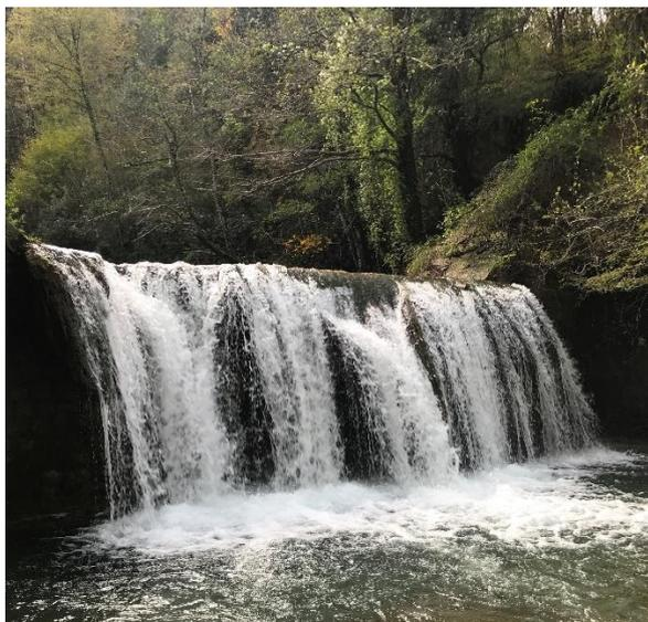
Figura 3-5 Esempio di alterazione del corso del fiume Calore: briglia con salto di circa 3 metri
